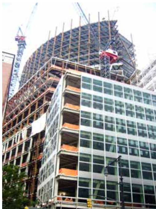
建設中の高級マンション
