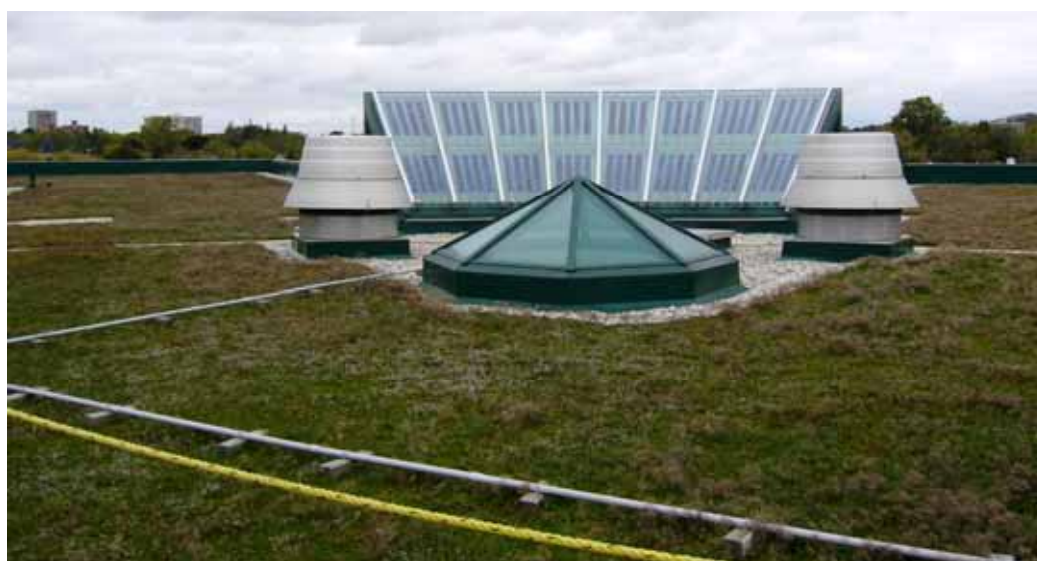
屋上緑化とソーラーパネル
