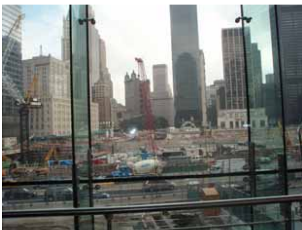
工事が進むワールドトレードセンター地域
